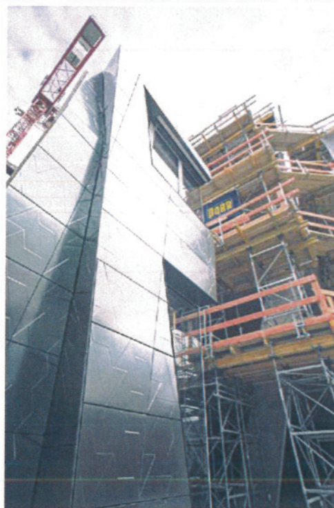
Zeit- und kostensparender Vorschlag der Hünnebeck Schalungsplaner: Das Lehrgerüst aus ID15 Rahmenstützen, das die Wandschalung der beiden Hauptfassaden trug, dient auch als Arbeitsgerüst für die Fassadenbauer. Links im Bild sieht man bereits einen Teil der Fassadenverkleidung aus Keramik-Titanium in dem Bemusterungsobjekt.
