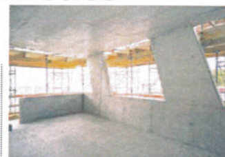
Um die Wände mit einer Systemschalung herstellen zu können, wurde im Vorfeld eine exakte Schalabfolge für alle Wandflächen entwickelt.
